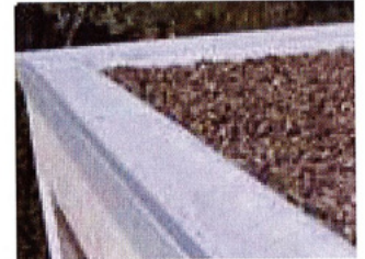
Flachdach mit Kiesfüllung
